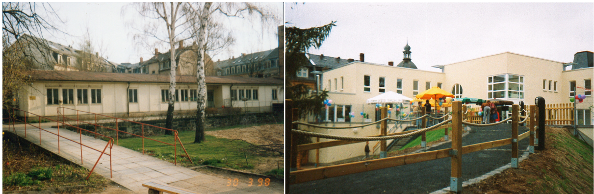
Der Kita-Flachbau im DDR-typischen Barackenstil vor dem Abbruch (März 1998) / Einweihung der Kita im August 1998. Fotos: Wolfgang Fiedler
